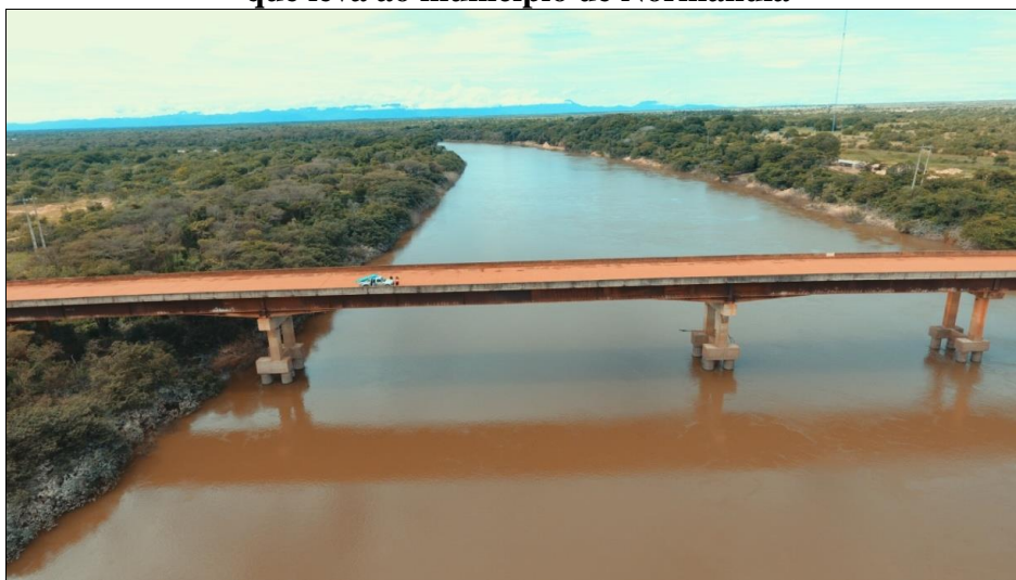
Figura 8 - Ponte sobre o Rio Itacutú BR-401 que leva ao município de Normandia
